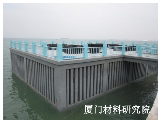
海水潮差试验平台
